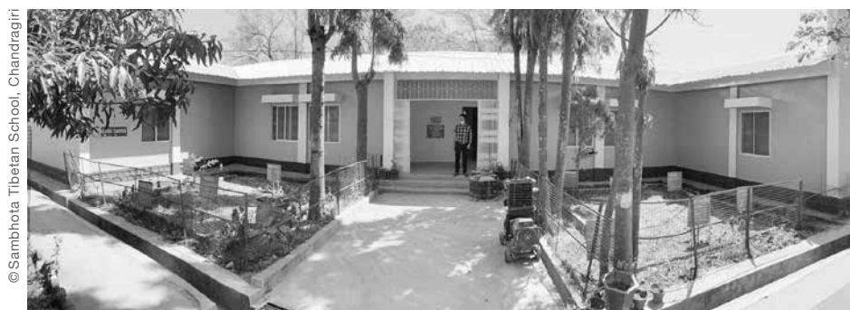
Aussenansicht der renovierten Schule. Eine gravierte Tafel beim Eingang würdigt die Unterstützung der Spender:innen.
