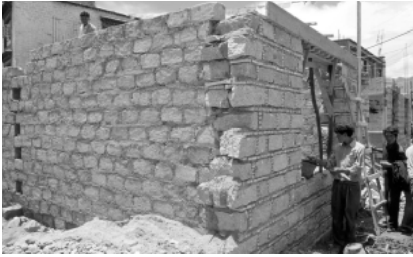
Die traditionelle Bauweise ist lediglich vorgetäuscht: Hinter einer scheinbar traditionellen Fassade verbirgt sich Zement.
