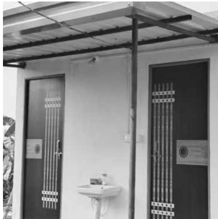
Dank Spenden aus der Schweiz war der Bau dieses WC-Hauses möglich.
